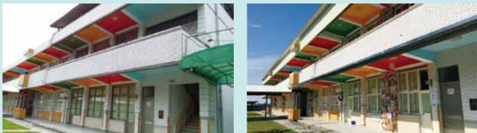
圖2.3 為校舍補強實際情況；部分柱採用擴柱補強，表面貼上磁磚美化，提升補強後附加價值（許庭瑋 攝）
