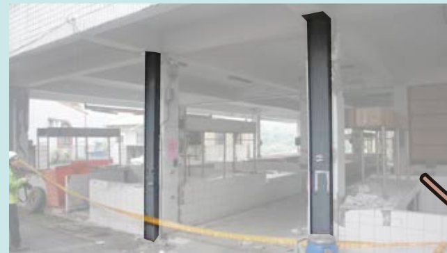
圖 1.4 某市場建築於美濃地震後未倒塌 (國震中心 攝)
