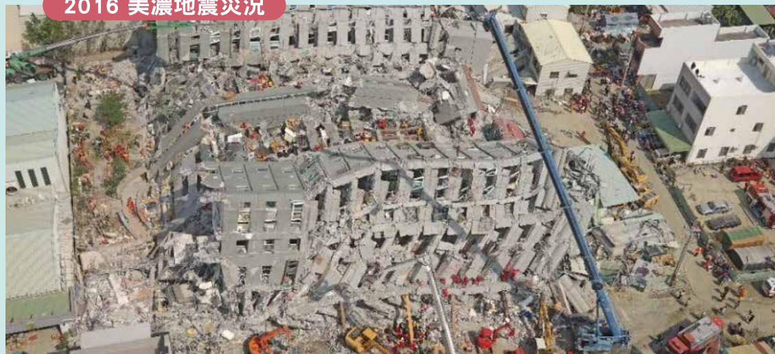
圖 2.2 臺南維冠金龍大樓倒塌（國震中心 攝）
