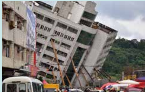
圖 1.3 雲門翠堤大樓震損照片 (國震中心 攝)
