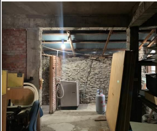
施工點內部照（西往東照）
