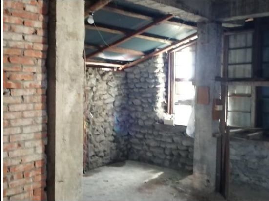
施工點內部照（西往東照）
