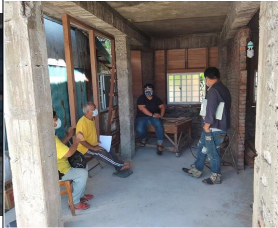
施工點內部照（南往北照）
